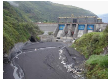
© Elizabeth Anderson : section asséchée de la rivière Pastaza en aval du barrage d'Agoyan, en Équateur.
