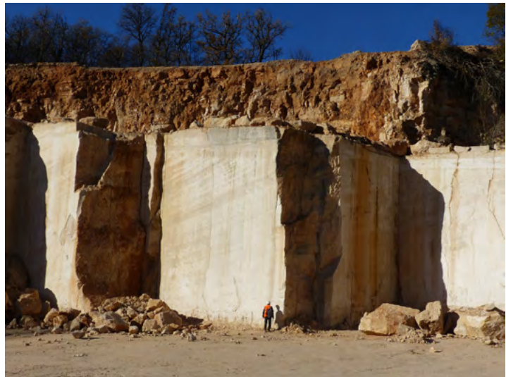
Front de taille d'une carrière extrayant de la pierre calcaire (© S.Andrieu - BRGM)
